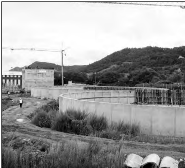
Durata estimată a lucrărilor este de 33 de luni
